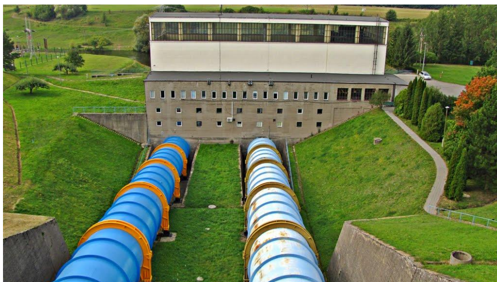
Rys. 22 Elektrownia wodna Koronowo, autor zdjęcia: Bogdan Polit
