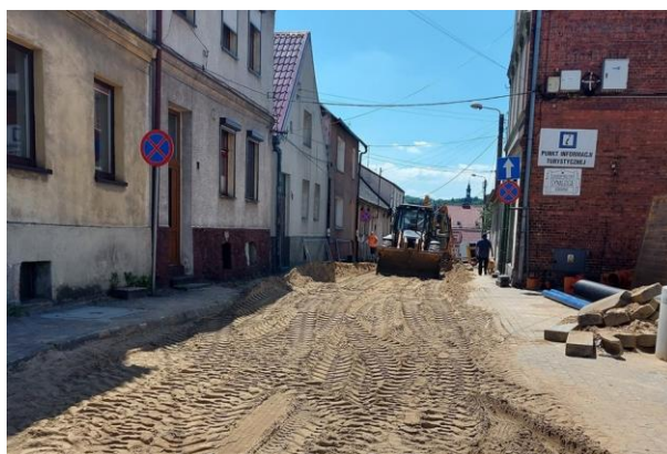
ul. Sienkiewicza w trakcie przebudowy
