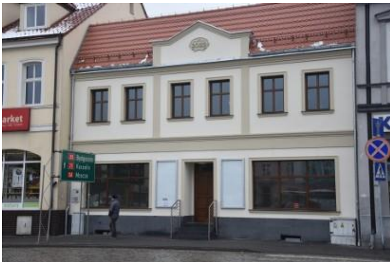
Punkt Informacji Turystycznej po przebudowie
