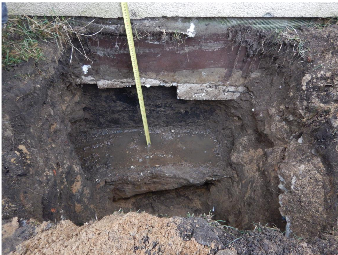
Fot. 15 Odkrywka fundamentów budynku „B”
