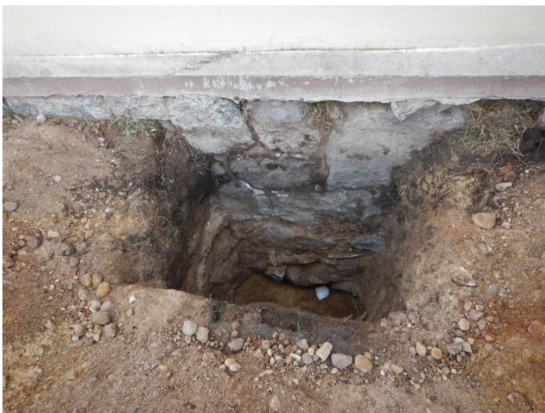
Fot. 14 Odkrywka fundamentów budynku „A”
