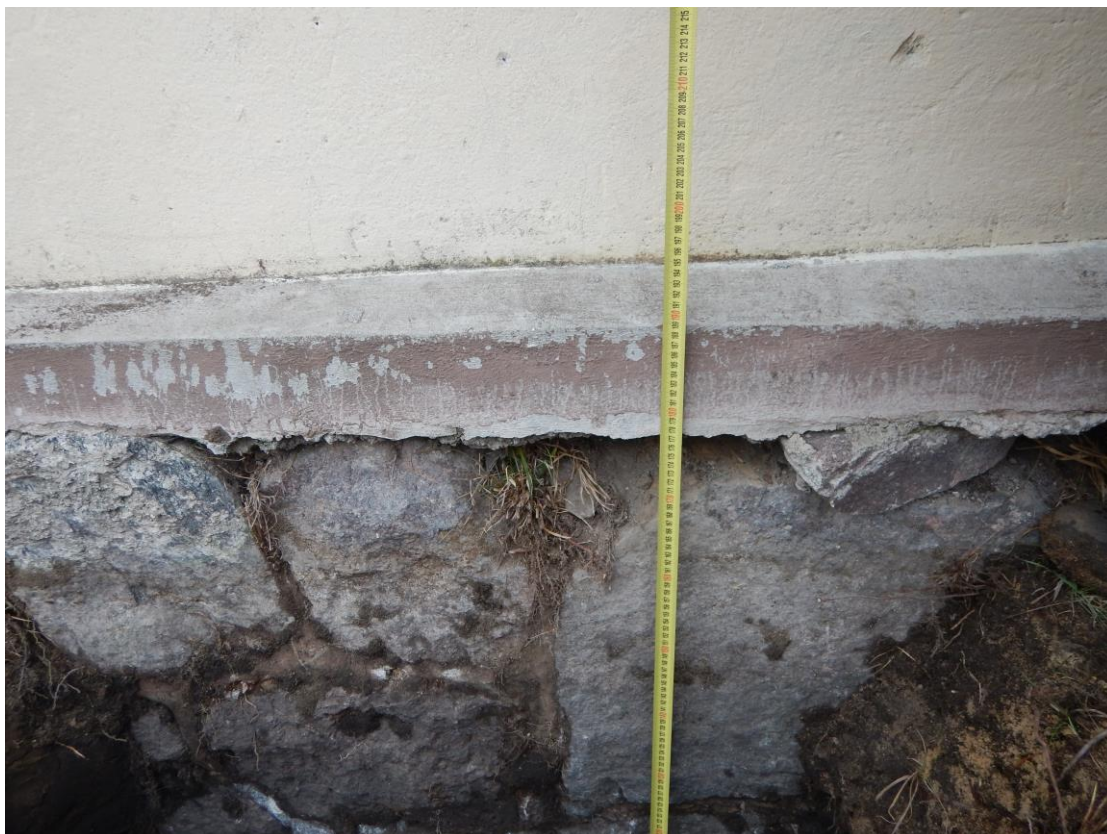
Fot. 13 Odkrywka fundamentów budynku „A”
