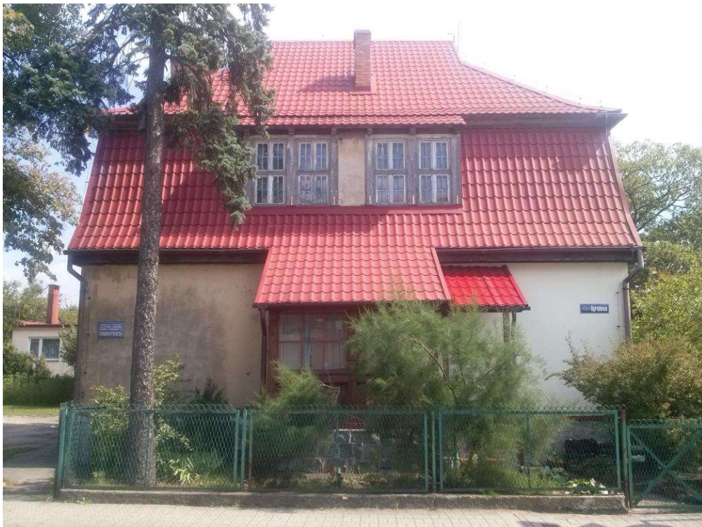
Fot.2 Elewacja Zachodnia
