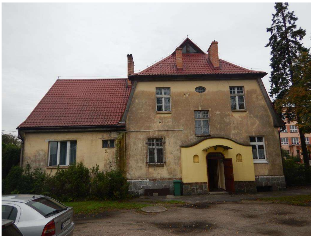
Fot.3 Elewacja Północna
