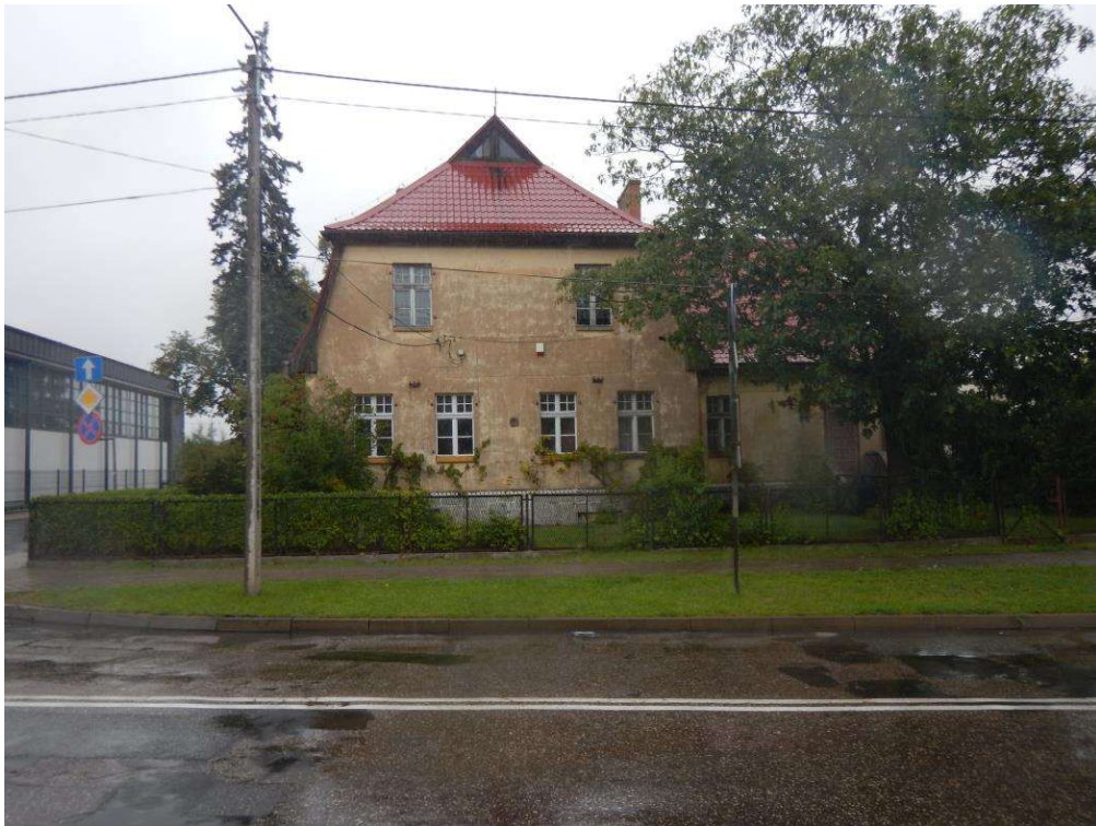
Fot.1 Elewacja Południowa
