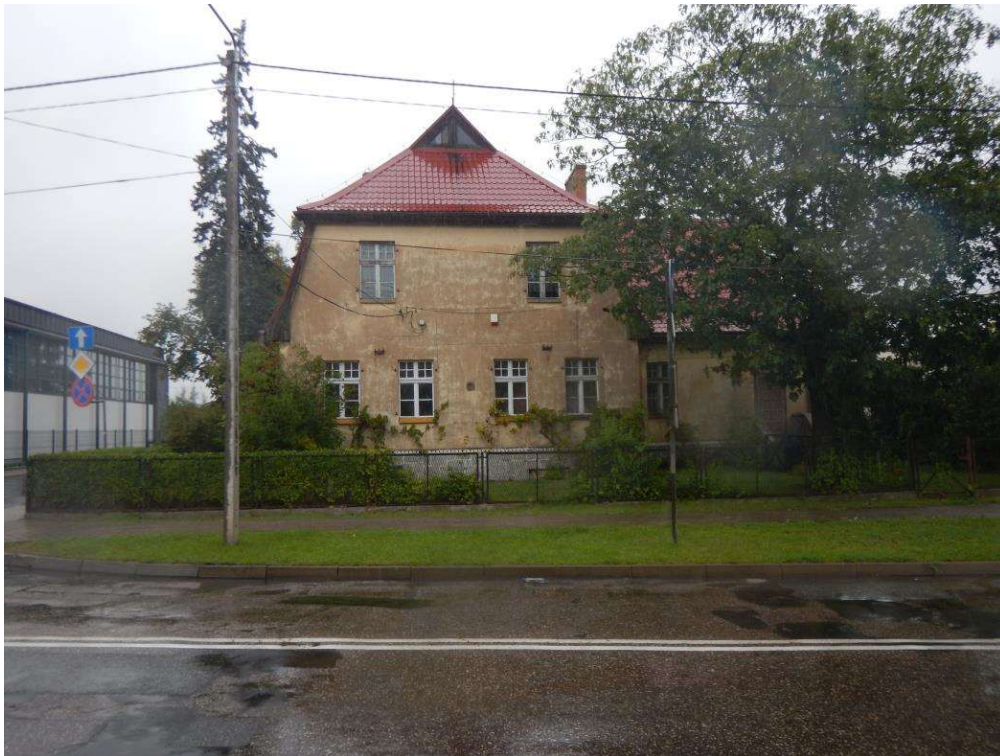
Fot.1 Elewacja Południowa
