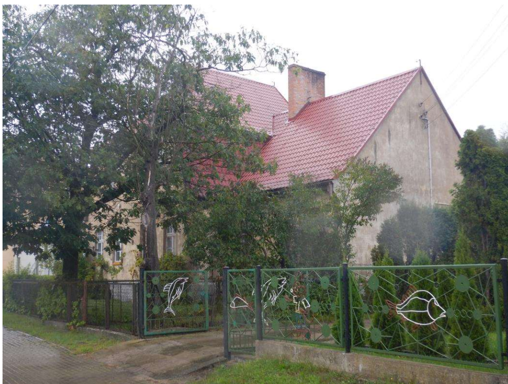
Fot.4 Elewacja Wschodnia
