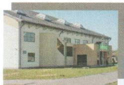
Hala sportowo – widowiskowa
