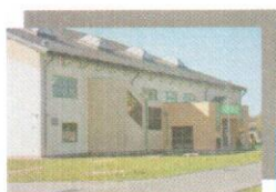
Hala sportowo – widowiskowa
