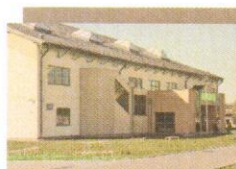
Hala sportowo – widowiskowa
