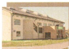
Hala sportowo – widowiskowa
