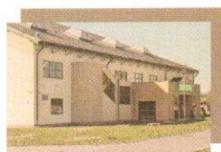
Hala sportowo – widowiskowa
