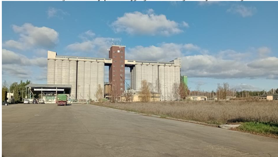
Fotografia nr 3. Widok na tereny zabudowy produkcyjnej i składowej z ulicy Zbożowej.
