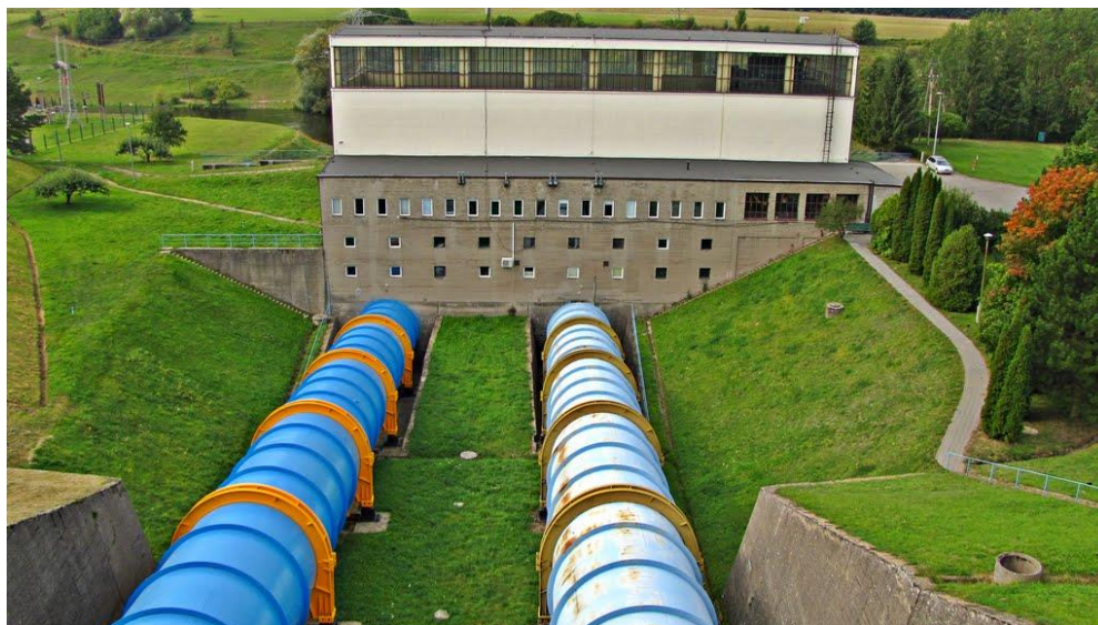
Rys. 18 Elektrownia wodna Koronowo, autor zdjęcia: Bogdan Polit
